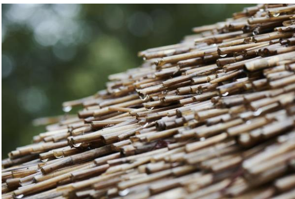
Les bottes de roseaux sont superposées. L'épaisseur du toit mesure entre 35 et 40 cm. © Jean-Baptiste Morel
